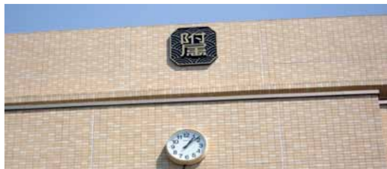
校舎正面上部に取り付けられた青海波
