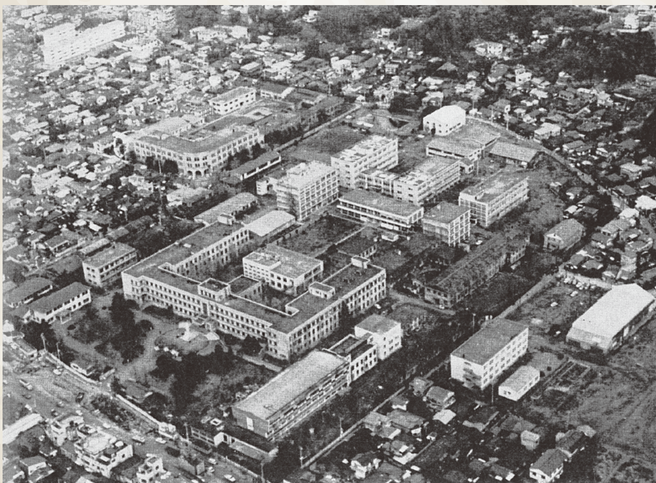
▲弘明寺校舎前身の国大工学部 校舎全景
